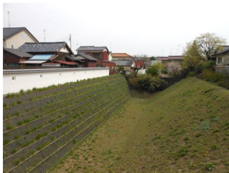
川越城中ノ門堀跡
