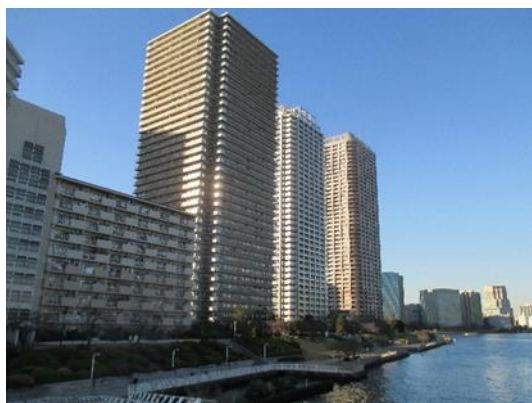
写真 2 大川端リバーシティ 21 (2015 年 12 月 20 日 小池拓矢 撮影)
